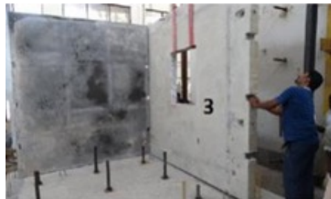
Rapid Assembly (1 storey per day)
